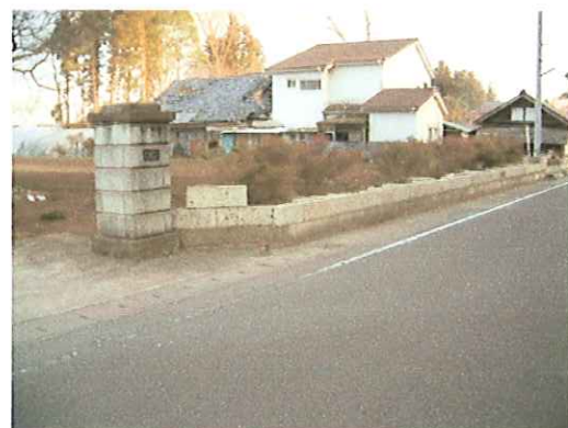
No. M-7 (真岡市下籠谷) 鉄筋なし大谷石塀 (全倒壊)
