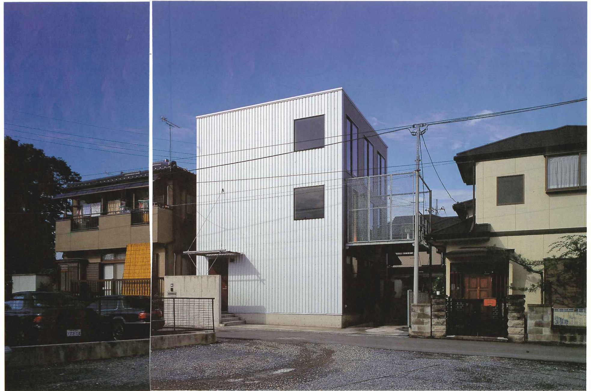
▲前面道路側外観/右側のテラスにはエキスパンドメタルのスクリーンがある
