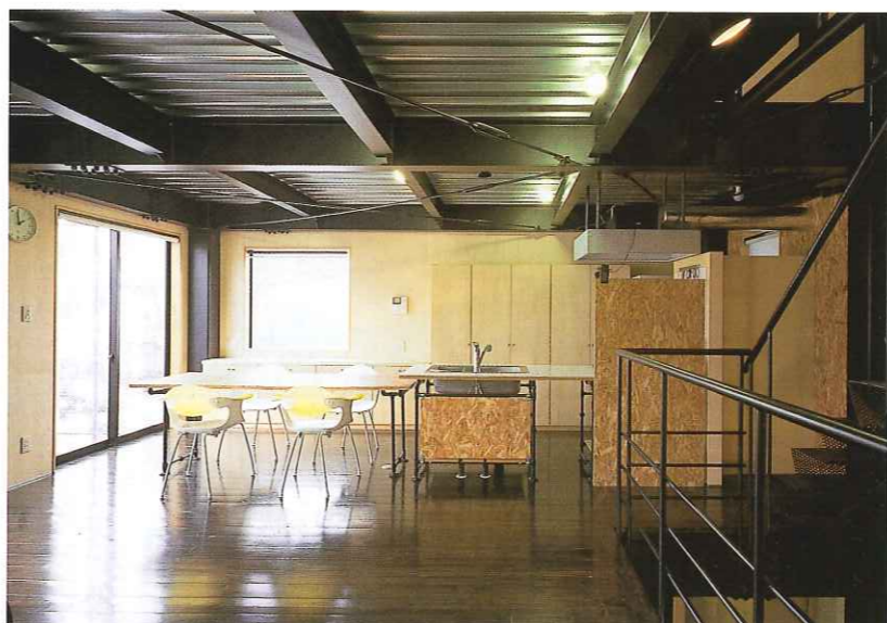
1階の親世帯居室と3階の子世帯居室のクッションの役目を果たすのが写真の2階リビング。中央に構えるのが、ガス管で骨格を組んで合板を乗せただけのキッチンカウンターとダイニングテーブル。剥き出しの鉄骨の梁とも相性がいい。
