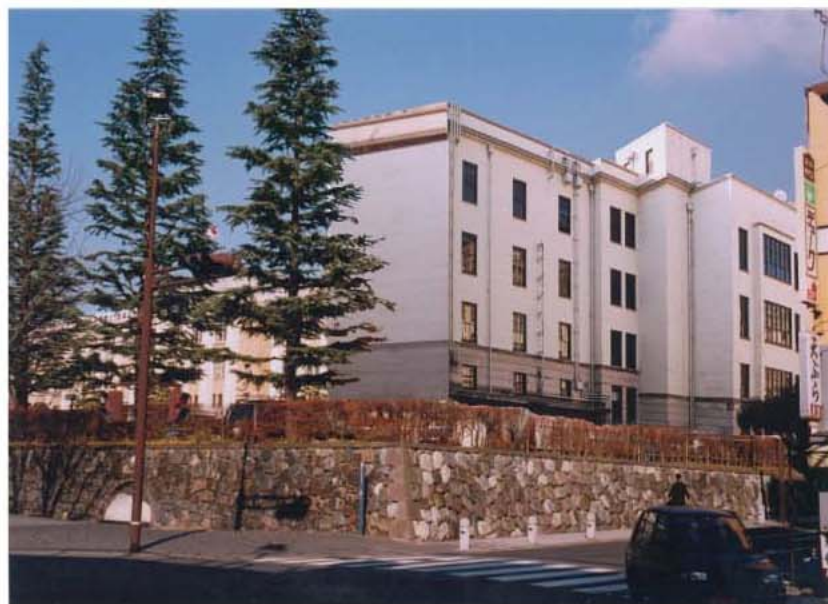
図4 (移築後の東側景観) 移築された本館が、通りに背を 向け景観が損なわれてしまう。
